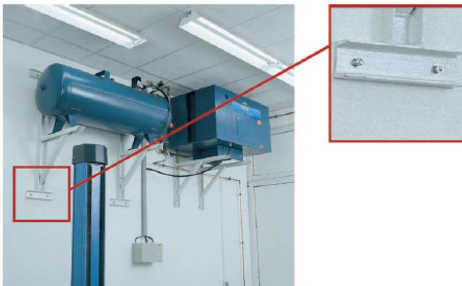
Figura 2.11: Fijación de equipamientos con Würth WFAZ/S, M12.
